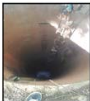
Figure 7 : Evacuation des eaux usées à l'Est de l'arrêt de bus 119
