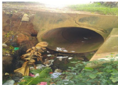
Figure 4 : Buse d'évacuation des eaux usées à l'Est du conaco médecine
